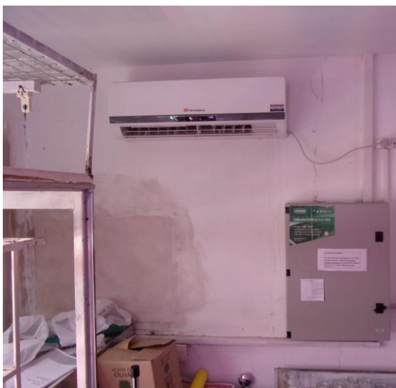
Figura 2. Detalle del equipo de aire acondicionado, panel de control de luces y timer y Manuales.
